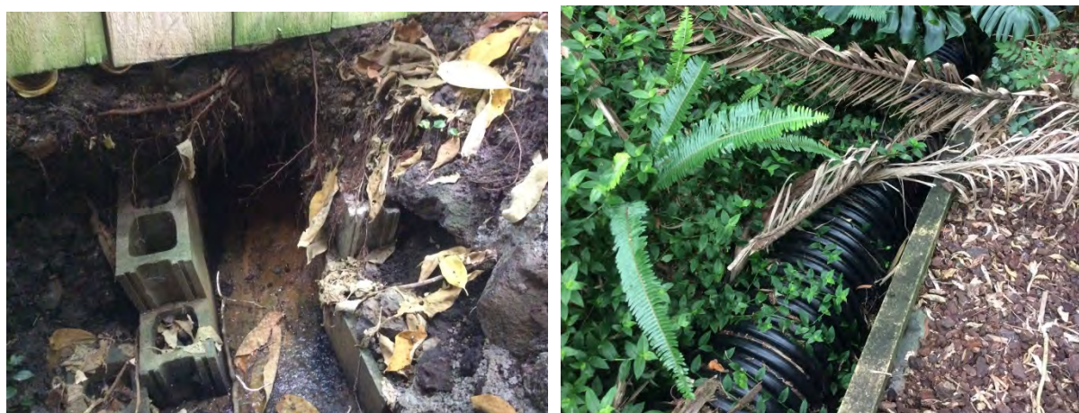
Cinder block culvert GLDSP_011.
